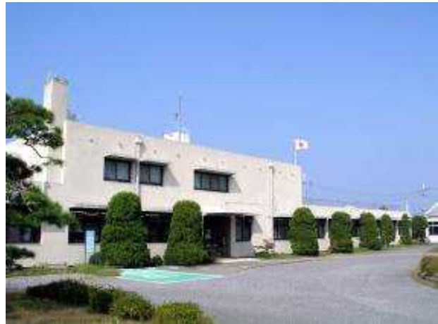
水産試験場本館
