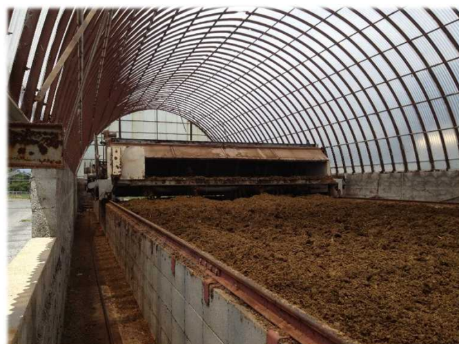
発酵堆肥化施設
